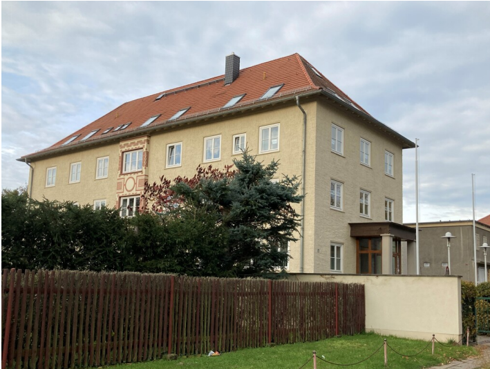
Ehemaliges Verwaltungsgebäude der Bergmanns-Wohnstättengesellschaft Borna, Blick von Südosten auf dekorierten Erker Fotograf/Urheber: Josephine Dressler
