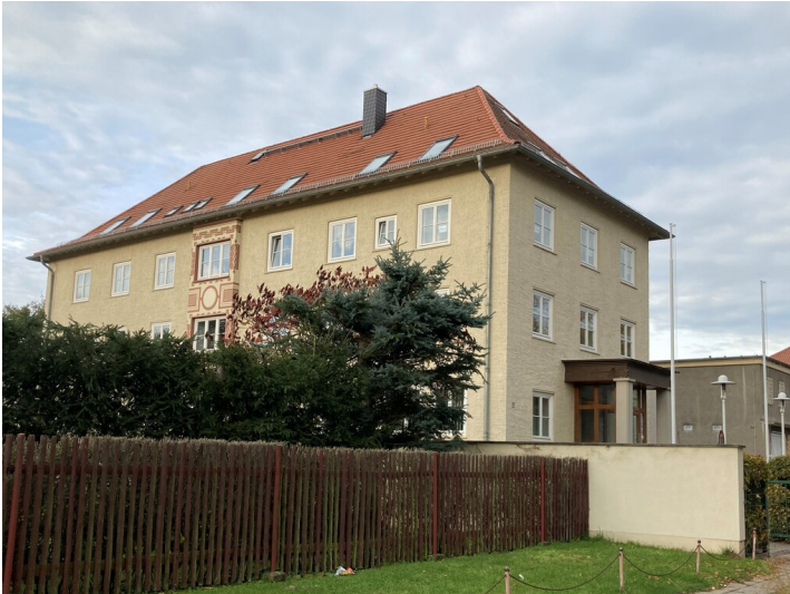
Ehemaliges Verwaltungsgebäude der Bergmanns-Wohnstättengesellschaft Borna, Blick von Südosten auf dekorierten Erker Erker Fotograf/Urheber: Josephine Dressler
