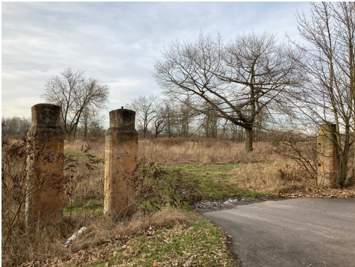
Drei Torpfelder der einstigen Brikettfabriken I, II »Dora und Helene« in Großzössen, straßenseitige Ansicht, im Hintergrund das brache, einstige Werksgelände Fotograf/Urheber: Josephine Dressler
