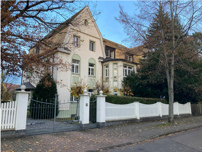
Siedlung der ehemaligen Beamten-Wohnhauskolonie der Witznitzer Kohlenwerke, hier Doppelwohnhaus für zwei Ingenieure von Westen blickend Fotograf/Urheber: Josephine Dressler
