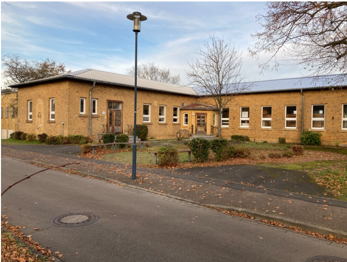
Küche mit Speisesaal der ehemaligen Brikettfabrik Witznitz, Blick von Südwesten Fotograf/Urheber: Josephine Dressler
