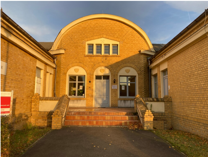
Kaue der ehemaligen Brikettfabrik Witznitz, straßenseitiger Eingangsbereich Fotograf/Urheber: Josephine Dressler
