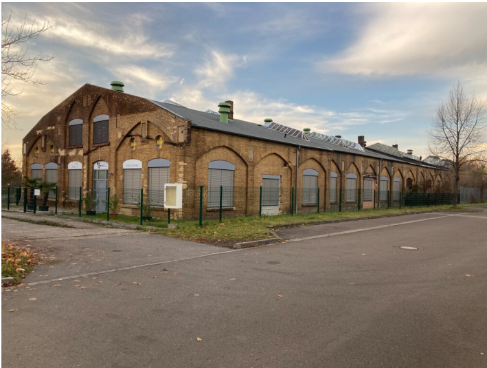
Werkstattgebäude der ehemaligen Brikettfabrik Witznitz, Südteil, Blick von Südosten Fotograf/Urheber: Josephine Dressler
