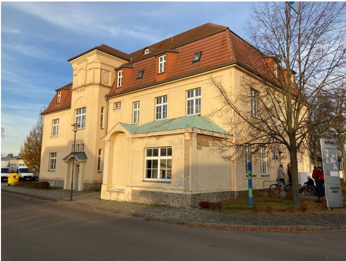
Verwaltungsgebäude der ehemaligen Brikettfabrik Witznitz, Fassade von Südwesten Fotograf/Urheber: Josephine Dressler
