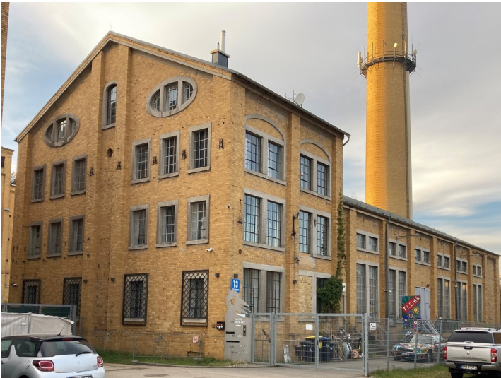
Maschinenhaus der ehemaligen Brikettfabrik Witznitz, Blick von Südost Fotograf/Urheber: Josephine Dressler
