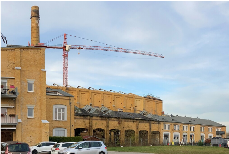
Pressenhaus der ehemaligen Brikettfabrik Witznitz, Blick von Südwesten, links das Kühlhaus, dahinter Trockendienst Fotograf/Urheber: Josephine Dressler
