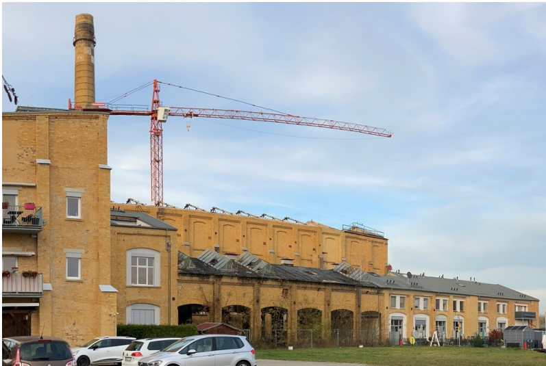
Pressenhaus der ehemaligen Brikettfabrik Witznitz, Blick von Südwesten, links das Kühlhaus, dahinter Trockendienst Fotograf/Urheber: Josephine Dressler
