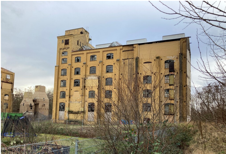
Nassdienstgebäude der ehemaligen Brikettfabrik Witznitz, Blick von Nordost. Fotograf/Urheber: Josephine Dressler
