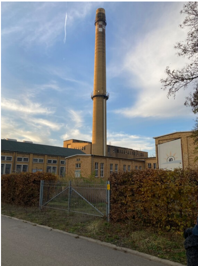
Schornstein der Brikettfabrik Witznitz (ehem.) von Südosten, davor Maschinenhaus Fotograf/Urheber: Josephine Dressler
