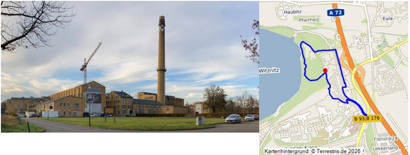
Ehemalige Brikettfabrik Witznitz, v.l.n.r. Kühl-, Pressenhaus, Trockendienst, Maschinenhaus, Schornstein, dahinter neues Kesselhaus, Schaltwarte, von Südosten blickend Fotograf/Urheber: Josephine Dressler
