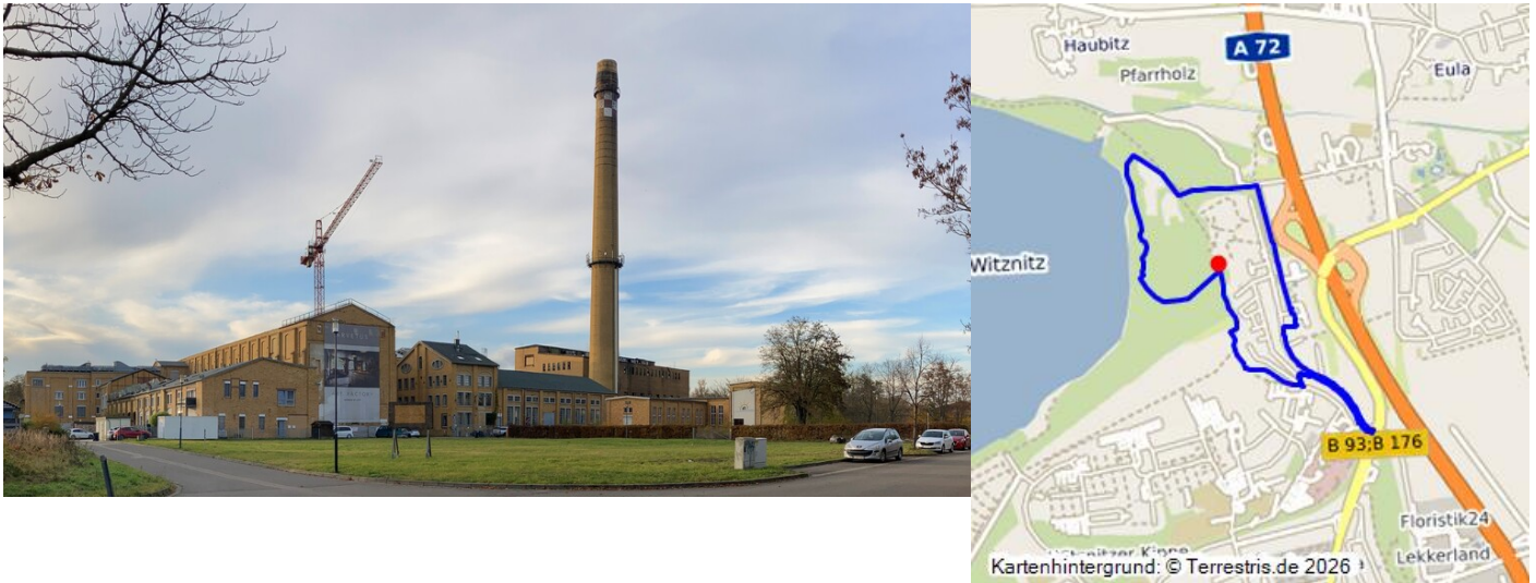
Ehemalige Brikettfabrik Witznitz, v.l.n.r. Kühl-, Pressenhaus, Trockendienst, Maschinenhaus, Schornstein, dahinter neues Kesselhaus, Schaltwarte, von Südosten blickend Fotograf/Urheber: Josephine Dressler
