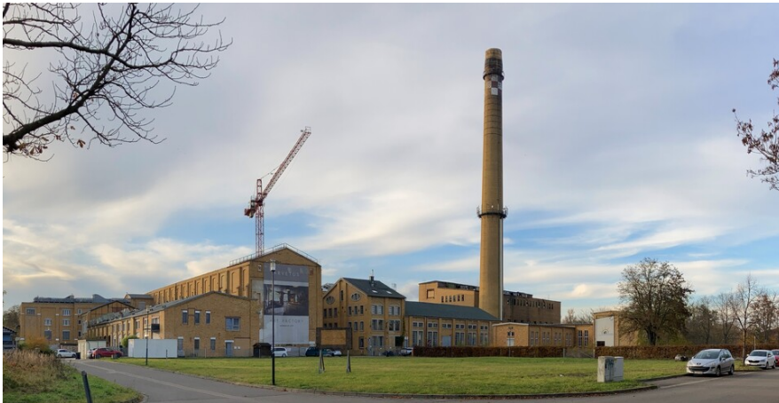
Ehemalige Brikettfabrik Witznitz, v.l.n.r. Kühl-, Pressenhaus, Trockendienst, Maschinenhaus, Schornstein, dahinter neues Kesselhaus, Schaltwarte, von Südosten blickend Fotograf/Urheber: Josephine Dressler
