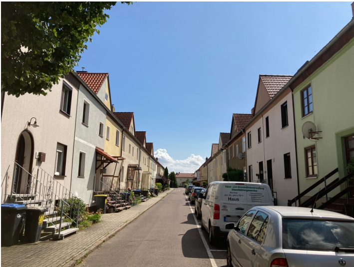
Teil der Siedlung an der ehemaligen Kasernenstraße, spiegelsymmetrisch angeordnete Reihenhäuser mit je Seite zehn Einfamilienhäusern, Blick nach Süden Fotograf/Urheber: Josephine Dressler
