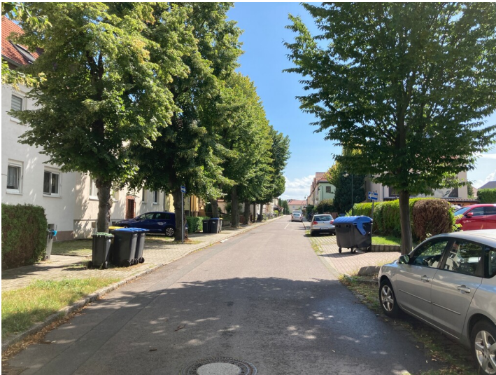
Siedlung an der ehemaligen Kasernenstraße der Bergmanns-Wohnstättengesellschaft Borna mbH, hier Blick nach Süden in der Leibnizstraße Fotograf/Urheber: Josephine Dressler
