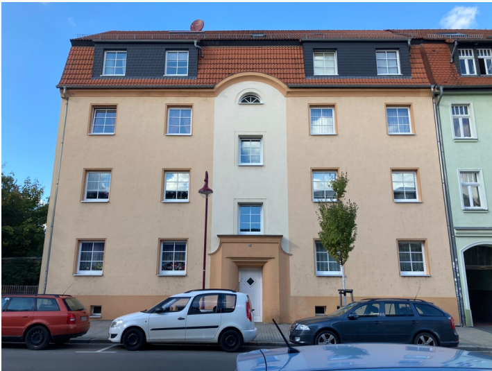
Mietshaus von Süden Fotograf/Urheber: Josephine Dressler
