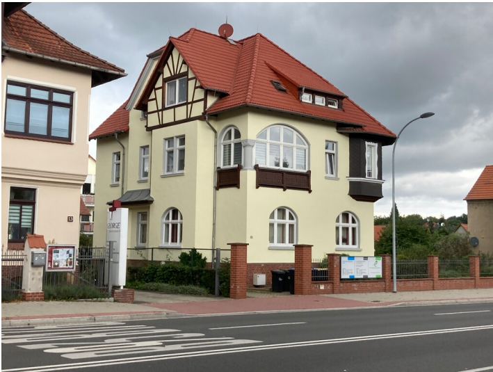
Fabrikantenvilla der Marie Rose, später Direktorenvilla von Wilhelm Gebhardt, Blick von Süden Fotograf/Urheber: Josephine Dressler
