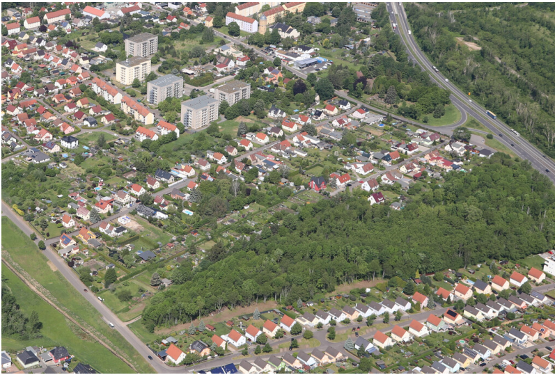
Siedlung, bestehend aus 30 Einfamilien- und 30 Doppelwohnhäusern, Schrägluftbild von Südost Fotograf/Urheber: Ronald Heynowski
