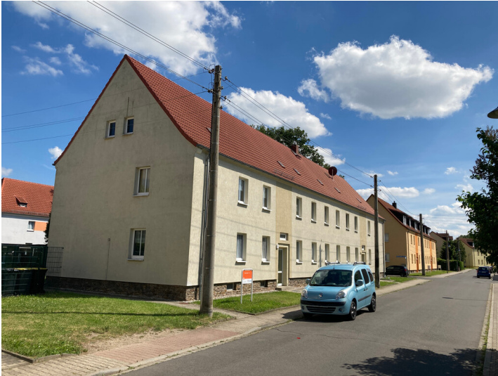
Siedlungsteil, bestehend aus zwei traufständigem Doppelhäusern beidseits der querenden Richard-Wagner-Straße, Blick nach Südost in die Mozartstraße Fotograf/Urheber: Nils Schinker
