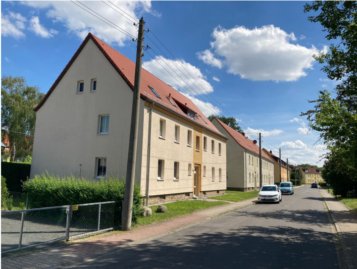
Siedlungsteil, bestehend aus vier traufständigem Wohnblöcken mit zwei Einzel- und zwei Doppelhäusern, Blick nach Südost in die Mozartstraße Fotograf/Urheber: Nils Schinker
