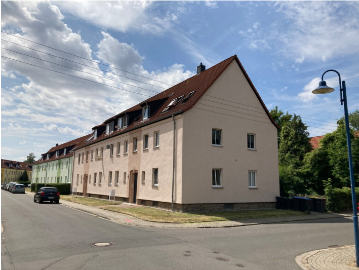
Siedlungsteil, bestehend aus traufständigem Wohnhaus, Blick nach Südwest in die Mozartstraße Fotograf/Urheber: Nils Schinker
