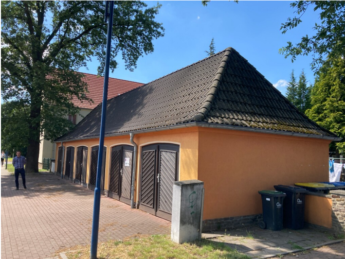
Garagegebäude, Blick nach Nordwest in die Richard-Wagner-Straße Fotograf/Urheber: Nils Schinker
