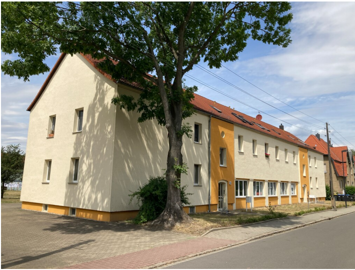
Wohnblock mit zwei Ladeneinheiten, Blick nach Nordwest in die Karl-Bartelmann-Straße Fotograf/Urheber: Nils Schinker
