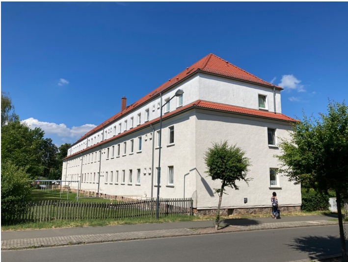
Siedlungsteil, bestehend aus drei Wohnblöcken mit je vier Sechsfamilienhäusern, Blick nach Nordost Fotograf/Urheber: Nils Schinker
