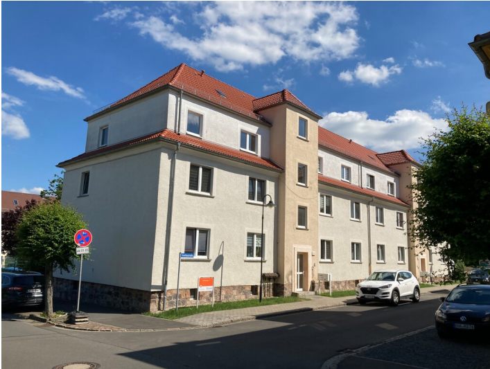
Siedlungsteil, bestehend aus acht Wohnblöcken mit 15 Sechsfamilienhäusern und einem Dreifamilienhaus, Straßenansicht mit Eingang Fotograf/Urheber: Nils Schinker
