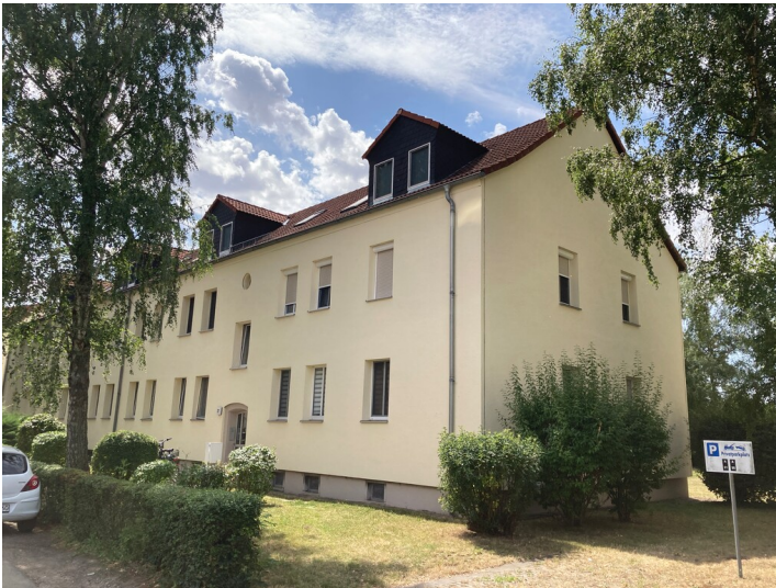
Siedlungsteil, bestehend aus drei Wohnblöcken mit je zwei Sechsfamilienhäusern, Blick nach Südwest in die Joseph-Haydn-Straße Fotograf/Urheber: Nils Schinker
