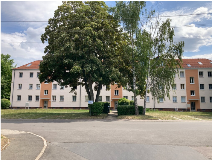
Wohnblock, bestehend aus drei Mehrfamilienhäusern, Blick nach Osten Fotograf/Urheber: Nils Schinker
