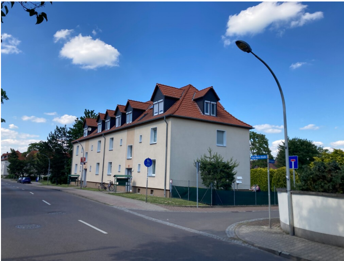
Siedlungsteil, bestehend aus elf Wohnblöcken mit insgesamt 25 Vierfamilienhäusern, Blick nach Norden in die Karl-Marx-Straße Fotograf/Urheber: Nils Schinker
