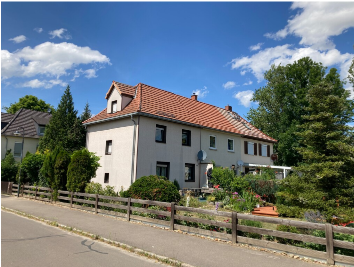
Siedlungsteil, bestehend aus fünf Zeilen mit je drei Reihenhäusern, Blick nach Norden Fotograf/Urheber: Nils Schinker
