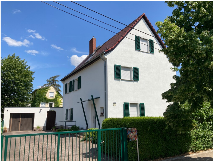
Siedlungsteil, bestehend aus vier Einfamilienwohnhäusern, Blick nach Nordost Fotograf/Urheber: Nils Schinker
