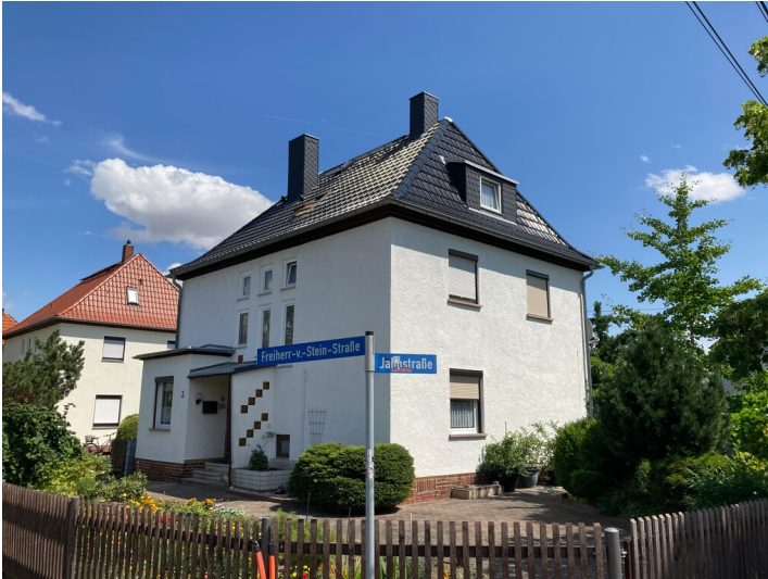
Siedlungsteil, bestehend aus vier Einfamilienwohnhäusern, Blick nach Osten Fotograf/Urheber: Nils Schinker
