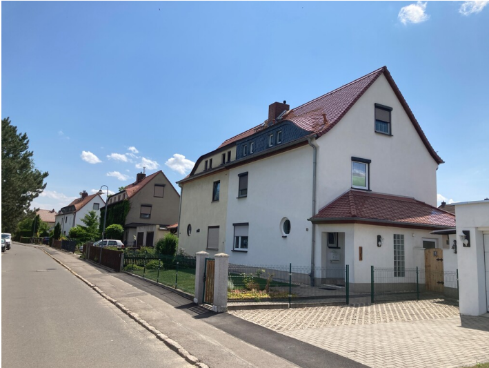
Siedlungsteil, bestehend aus zwölf Doppelwohnhäusern, Blick in die Straße Am Streitteich nach Südwest Fotograf/Urheber: Nils Schinker
