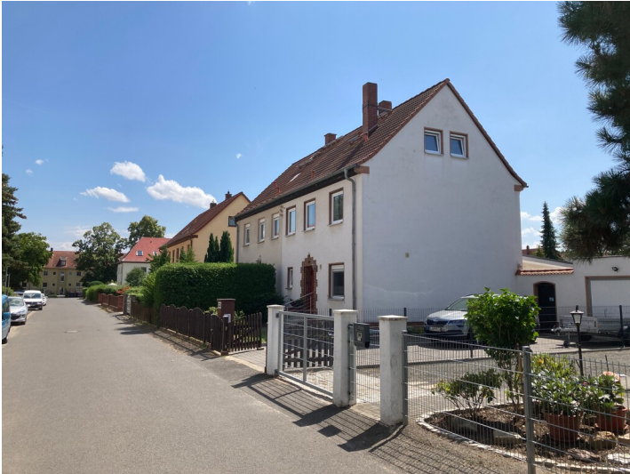
Siedlungsteil, bestehend aus zwölf Doppelwohnhäusern mit Garage, Schrägsicht Fotograf/Urheber: Nils Schinker
