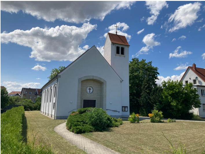
Kath. Kirche Böhlen; Blick nach Westen Fotograf/Urheber: Nils Schinker
