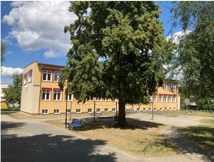
Kindergarten, in zwei Bauabschnitten errichtete Kindereinrichtung, Blick nach Norden Fotograf/Urheber: Nils Schinker
