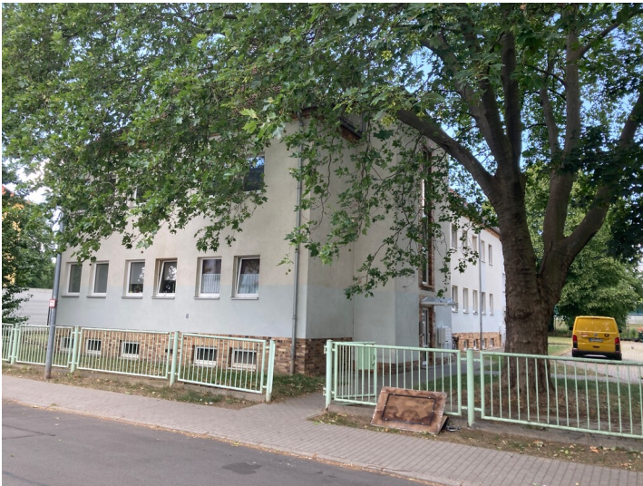
Kinderheim, zweigeschossiger Massivbau mit Walmdach, Blick nach Südwest Fotograf/Urheber: Nils Schinker
