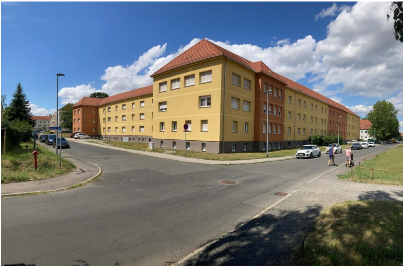
Ledigenwohnheim, sogenanntes »Bullenkloster«, dreigeschossige Zweiflügelanlage, Blick nach Nordwest Fotograf/Urheber: Nils Schinker
