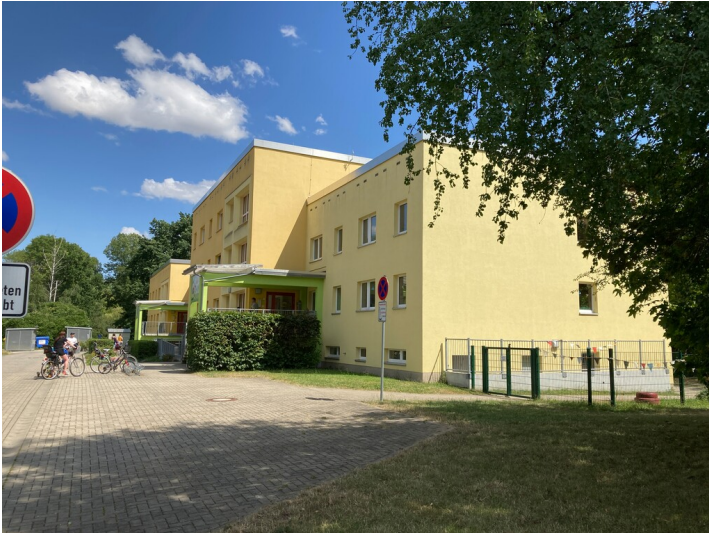
Kindertageseinrichtung, zweigeschossiger Typenbau mit dreigeschossigem Mittelteil, Blick nach Osten Fotograf/Urheber: Nils Schinker
