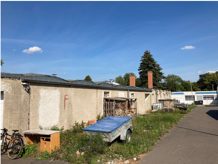
Barackenlager, eingeschossige Wohnbaracken mit Betonschalendach, Blick nach Norden Fotograf/Urheber: Ullrich Ochs
