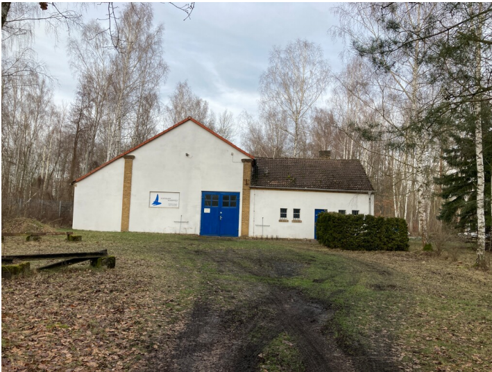
Ehemalige Pumpenstation, heute Bootshaus, Ansicht von Süden Fotograf/Urheber: Josephine Dressler
