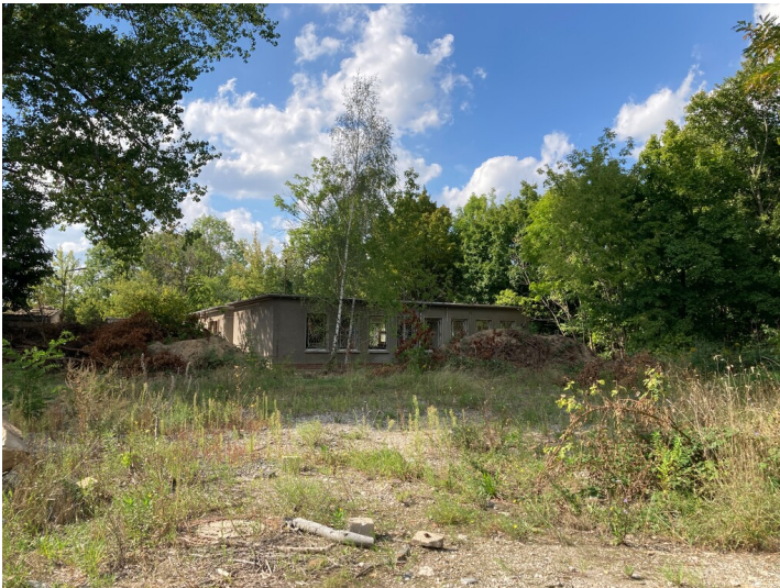
Flachbau, sogenannte Telefonerbaracke, Blick nach Nordwest Fotograf/Urheber: Nils Schinker
