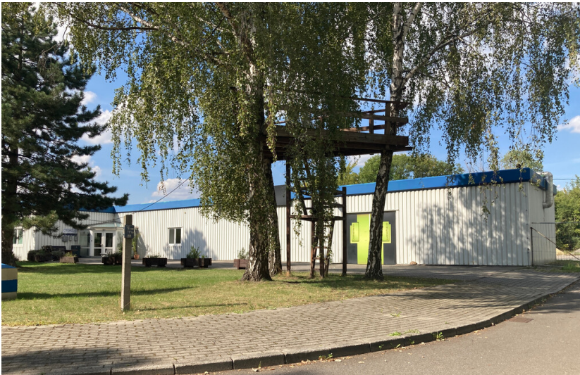
Ladengebäude, Ansicht von der Werkstraße nach Norden Fotograf/Urheber: Nils Schinker
