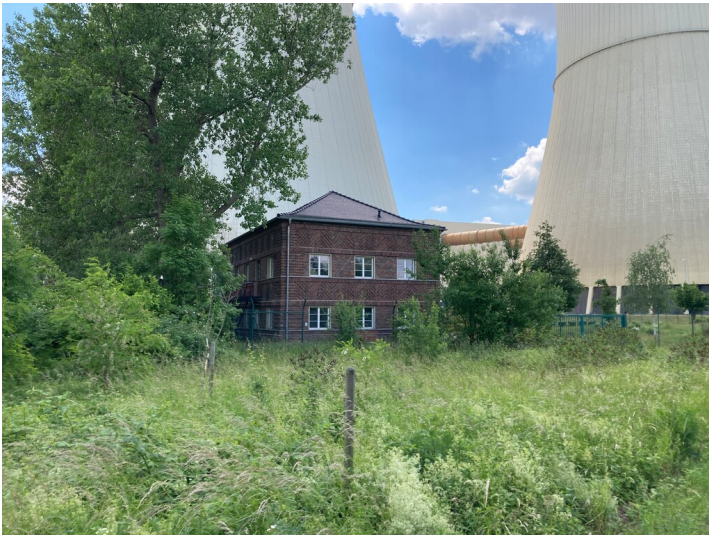
Verwaltungsbau, sogenanntes Archivgebäude, Blick von Norden in Richtung Kraftwerk Lippendorf Fotograf/Urheber: Nils Schinker
