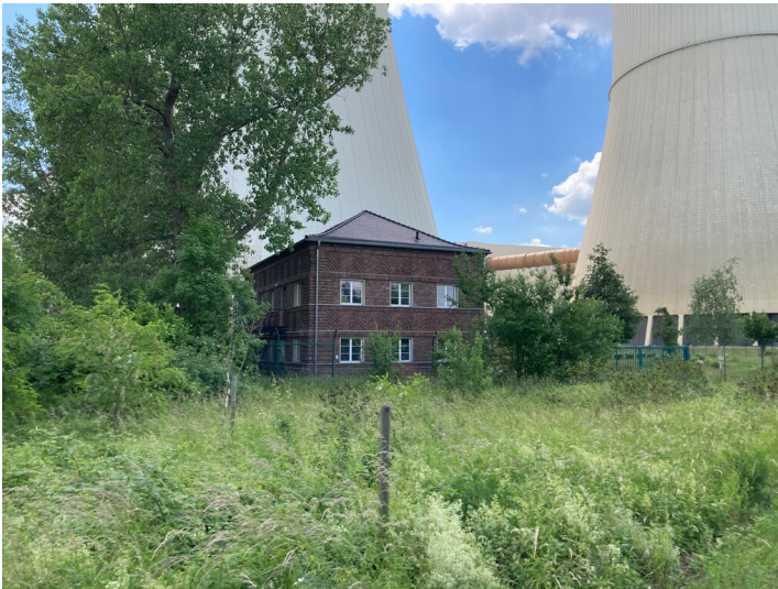
Verwaltungsbau, sogenanntes Archivgebäude, Blick von Norden in Richtung Kraftwerk Lippendorf Fotograf/Urheber: Nils Schinker
