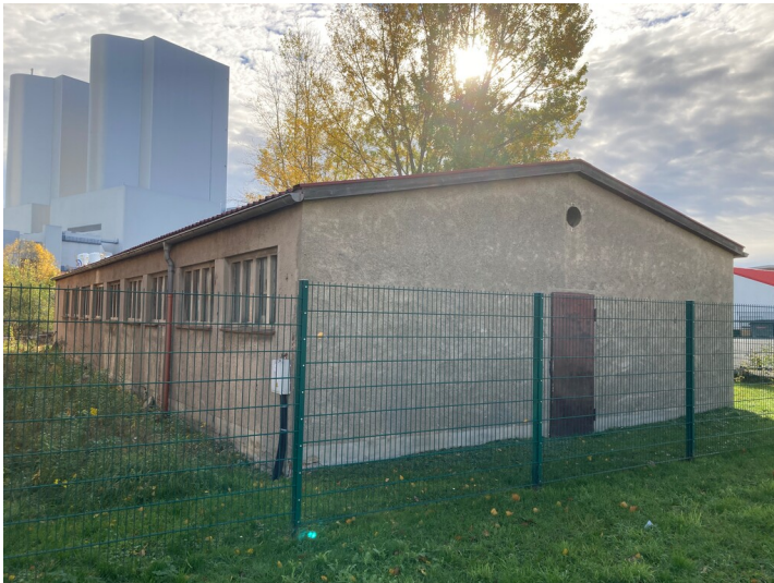
Lagegebäude, Blick nach Osten Fotograf/Urheber: Nils Schinker
