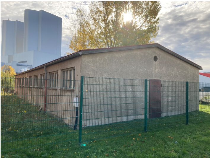
Lagegebäude, Blick nach Osten Fotograf/Urheber: Nils Schinker
