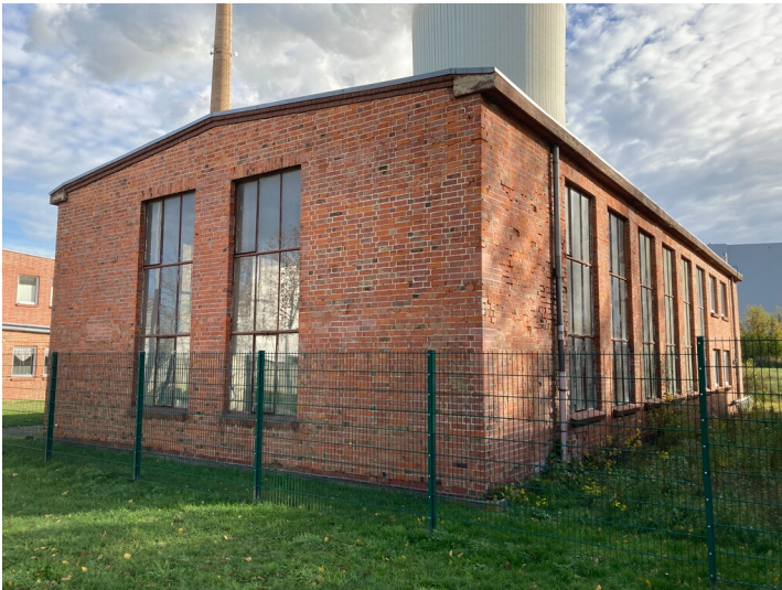
Werkstatthalle, sogenanntes Technikum, Blick nach Südost Fotograf/Urheber: Nils Schinker
