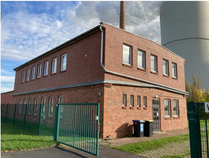
Verwaltungsbau, sogenanntes Technikum, Schrägansicht nach Nordost Fotograf/Urheber: Nils Schinker
