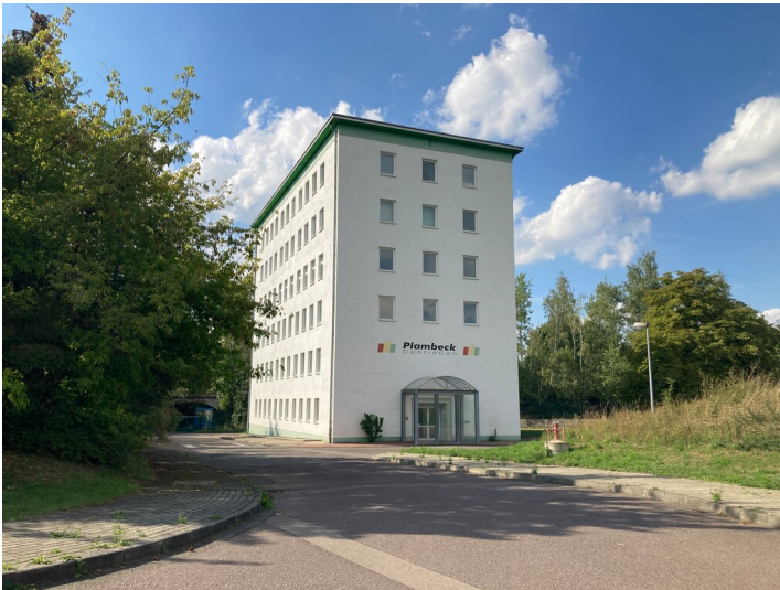
Verwaltungsbau, sogenanntes Büro der Ingenieurzentrale, Blick nach Nordwest Fotograf/Urheber: Nils Schinker
