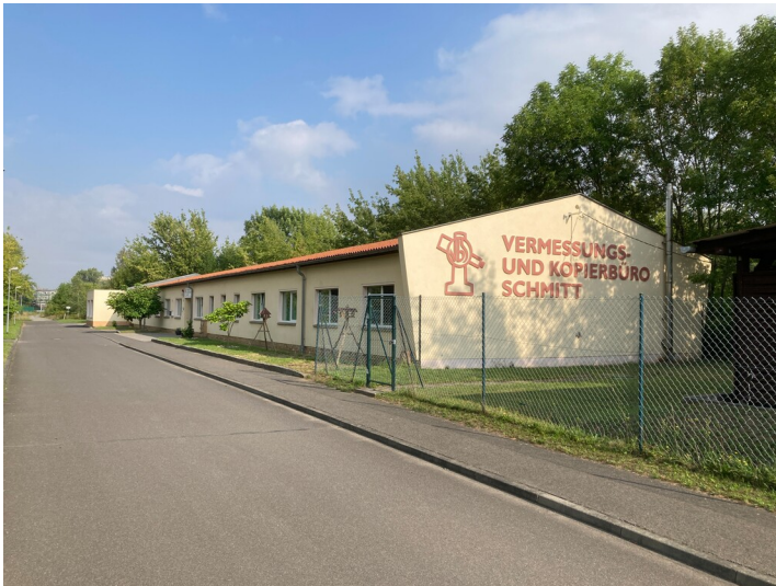
Verwaltungsbau, sogenanntes Büro für Aufbaustab, Blick nach Nordwest Fotograf/Urheber: Nils Schinker
