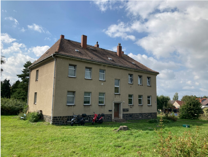
Zweigeschossiges Wohnhaus mit Walmdach, Blick von der Straße nach Nordwest Fotograf/Urheber: Nils Schinker
